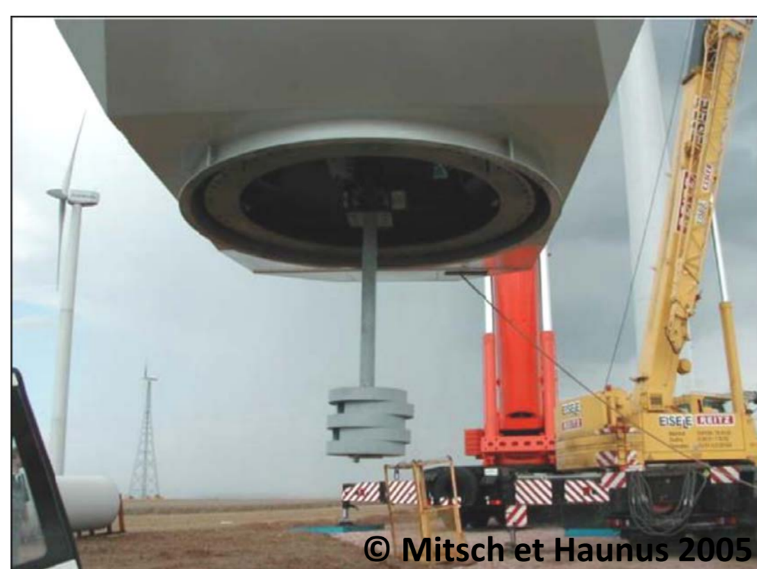
Prototyp eines Schwingungsdämpfers für Windenergieanlagen © Mitsch et Haunus 2005
