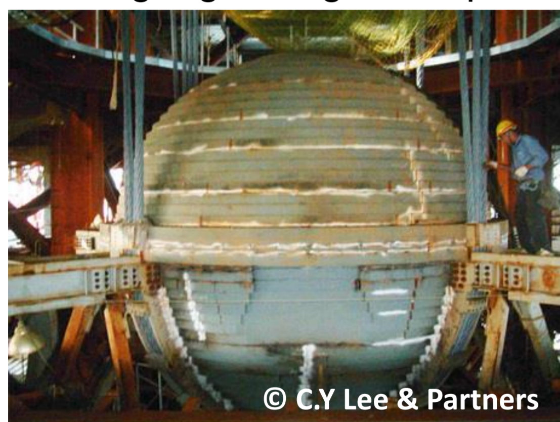
Tilgerpendel des Taipei 101, Taipei, Taiwan
